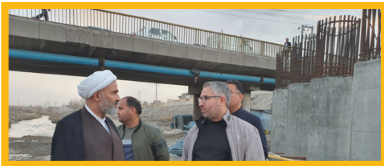
بازدید حجت‌الاسلام پژمان فر از روند عملیات تعریض پل دهرود
